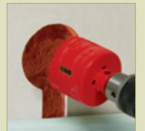
Perçage à la scie cloche Ø67 mm
