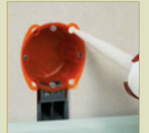
Fixation par étriers et/ou scellement par colle
