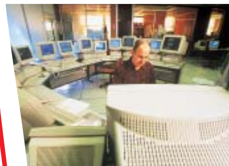
Applications critiques nécessitant deux sources électriques indépendantes.
