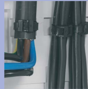
Tenue des câbles d'entrée en fond de coffret par simple collier (livré)
