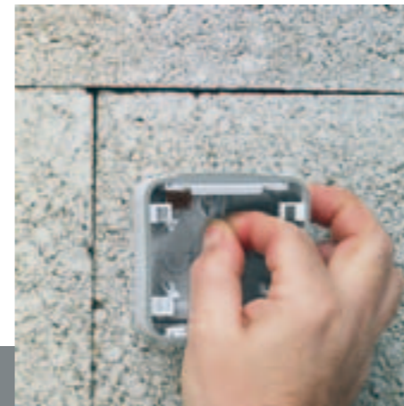
1/ Prédécoupe de l'embout en tirant sur l'opercule.
