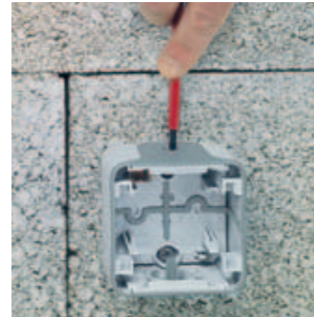
1/ Perforation de l'embout à l'aide d'un tournevis.
